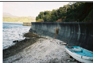
③護岸状況
