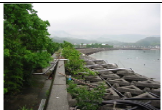
②護岸状況
