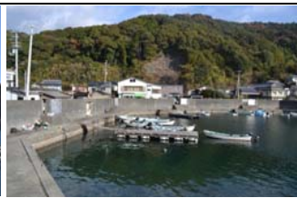
②護岸状況
