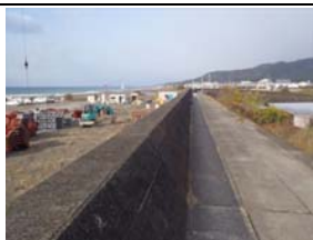
②護岸状況
