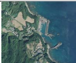
②海岸状況(航空写真)
