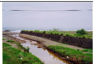
②護岸状況
