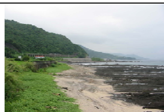
③護岸状況
