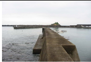
②堤防状況
