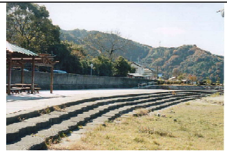
②護岸状況
