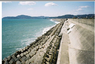
③護岸状況
