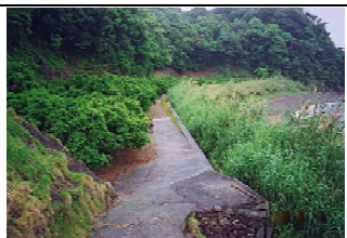
②護岸状況
