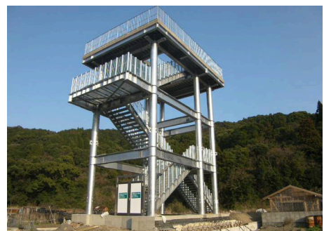
〔津波避難タワー（四万十町）〕
