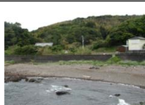
③護岸状況
