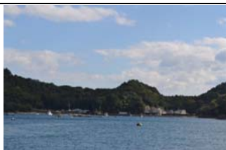
②護岸状況
