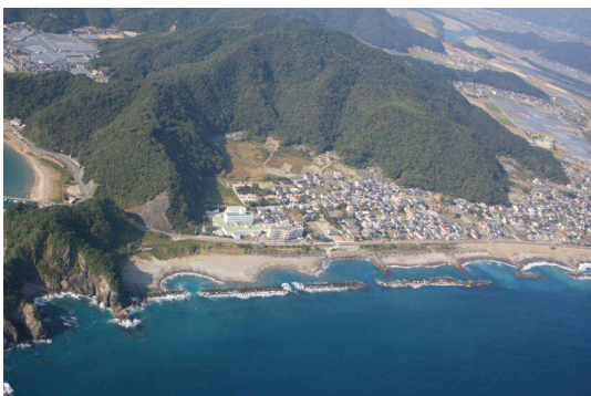
〔侵食対策事業の状況（新居海岸）〕
