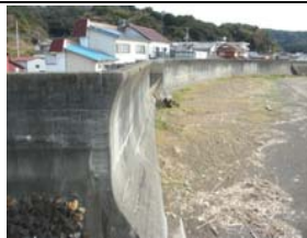
②護岸状況
