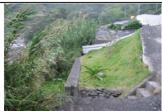
③護岸状況
