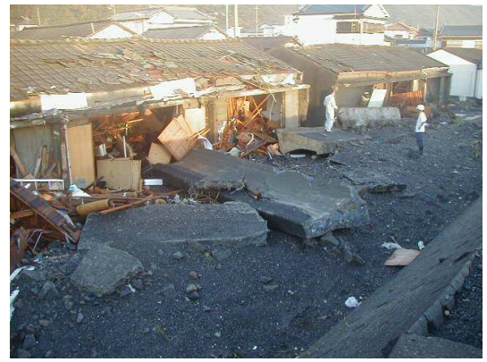
〔菜生海岸被災状況（室戸市）〕
