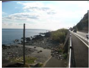
①護岸状況
