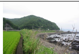
③護岸状況
