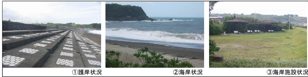
①護岸状況
