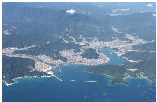
〔津波防波堤（須崎港）〕
