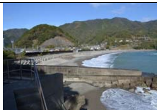
②護岸状況
