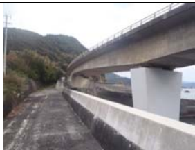
②護岸状況
