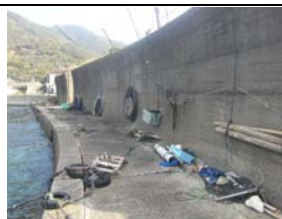
②護岸状況
