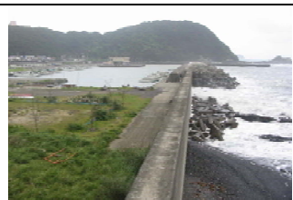
②防波堤状況
