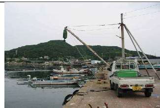
②護岸状況
