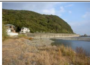
③護岸状況
