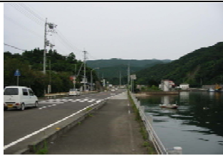
③護岸状況
