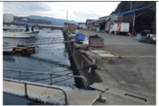
②護岸状況
