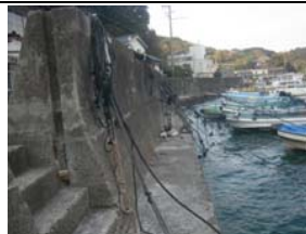
②護岸状況
