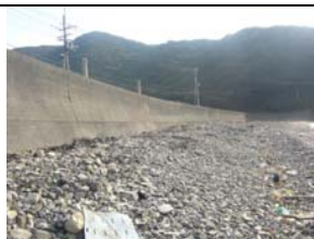
③護岸状況
