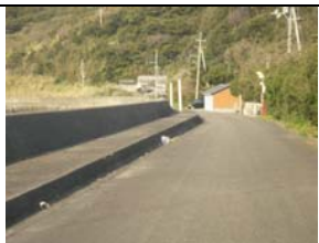
②護岸状況
