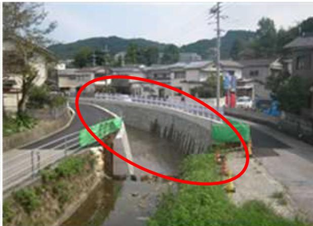
豪雨時の洪水被害防止を目指して川底の土砂を取り除いたり、河幅を拡げています。
