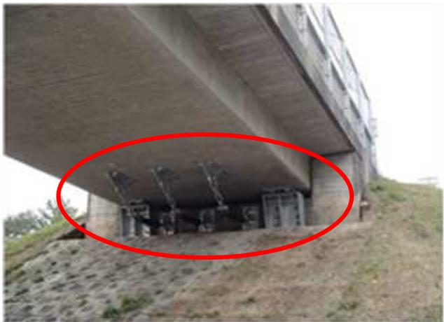
地震が発生した際にも耐えうるように橋の補強工事を行っています。
