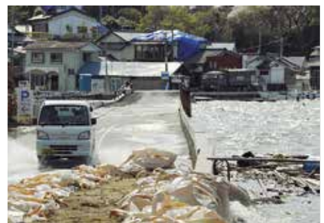
地盤沈下で地面が低くなり、大潮の満潮で冠水した道路を走る車＝宮城県東松島市(提供:共同通信社)
