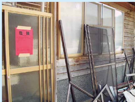
被害住家と被災建築物応急危険度判定結果 (提供：一般財団法人 消防科学総合センター)
