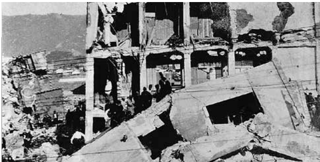
ビルの倒壊（高知市堺町付近）
