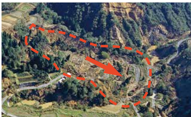
新潟県中越地震による地すべり (提供:アジア航測(株))
