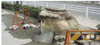
地面の液状化によるマンホールの隆起 = 千葉県浦安市 (提供: 一般財団法人 消防科学総合センター)
