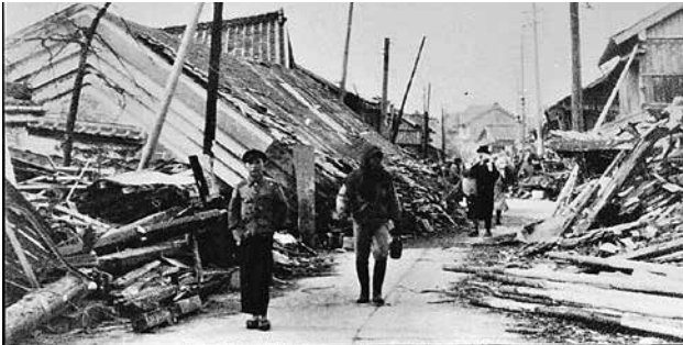
家屋の倒壊（四万十市中村大橋通二丁目付近）
