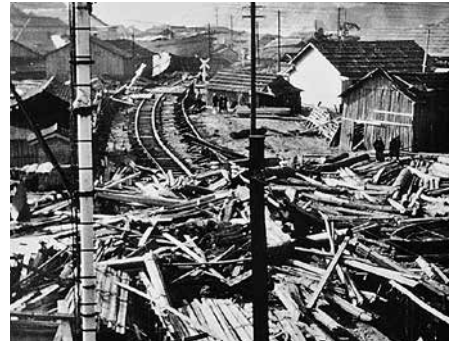
線路を津波による漂流物がふさぐ（須崎市浜町付近） 提供：須崎市
