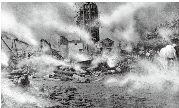
関東大震災 浅草十二階付近の火災 (大正12年9月1日/提供:共同通信社)
