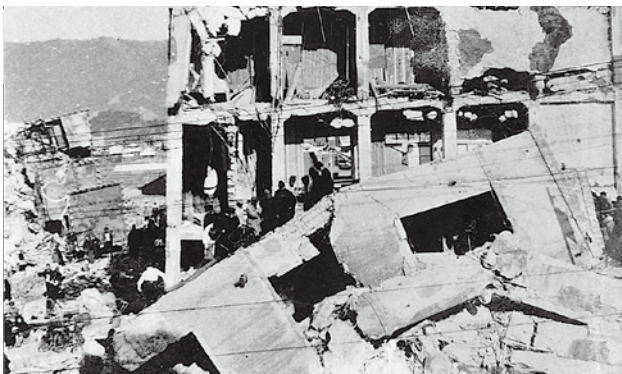
昭和南海地震の揺れでこわれたビル(高知市堺町付近)
