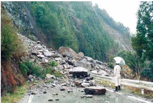
芸予地震による高知県土佐郡土佐町井尻のがけくずれ
