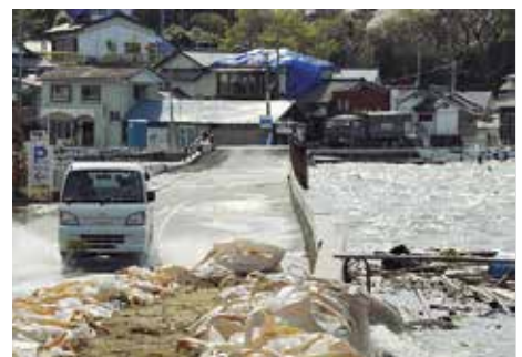
地盤沈下で地面が低くなり、大潮の満潮で冠水した道路を走る車＝宮城県東松島市(提供:共同通信社)
