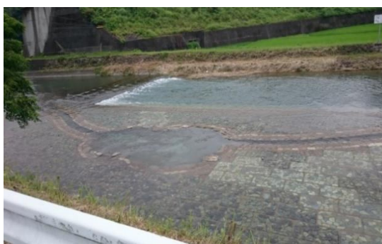
蜷川河川プール
