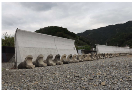
安和漁港海岸（海岸堤防の改良）
