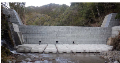
口神川砂防工事
