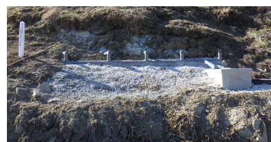
立割地すべり対策工事
