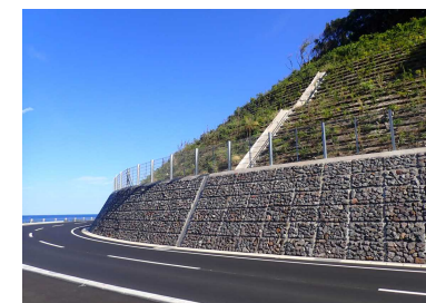
法面对策工事
