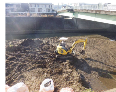
久万川浚渫工事
