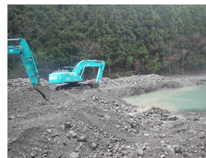
永瀬ダム浚渫工事
