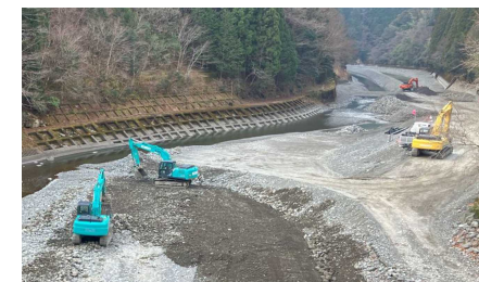
永瀬ダム浚渫工事（香美市）
