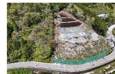
法面对策工事（いの町）
