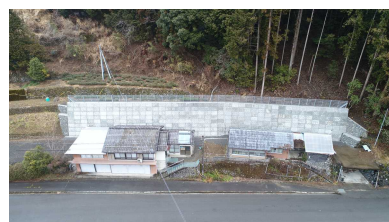
がけくずれ住家防災対策工事 （梶原町）
