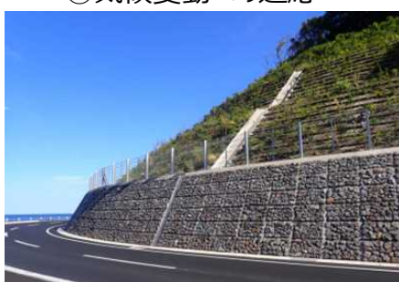
道路整備（法面对策）事業
