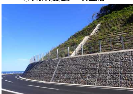
道路整備（法面对策）事業
