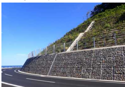
道路整備（法面对策）事業
