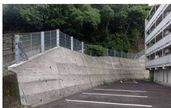
丸の内地区急傾斜地 崩壊対策工事（四万十市）
