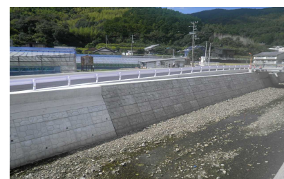
和食川改修工事（芸西村）
