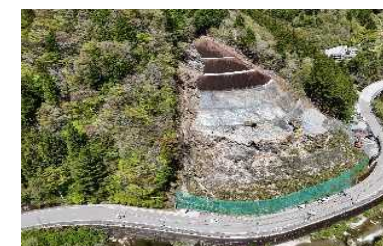
法面对策工事（いの町）
