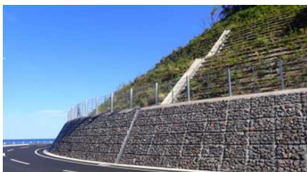
道路整備（法面对策）事業
