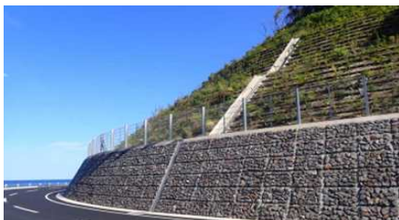
道路整備（法面对策）事業
