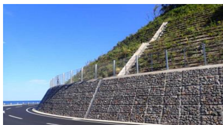
道路整備（法面对策）事業
