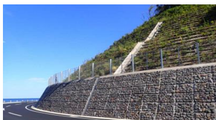
道路整備（法面对策）事業
