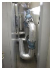
積算熱量計の取付に際して 実施したバイパス工事部分
