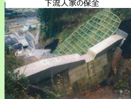
砂防堰堤の整備による下流人家の保全
