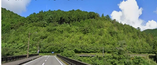
県道窪川船戸線一斗俵工区（四万十町）
