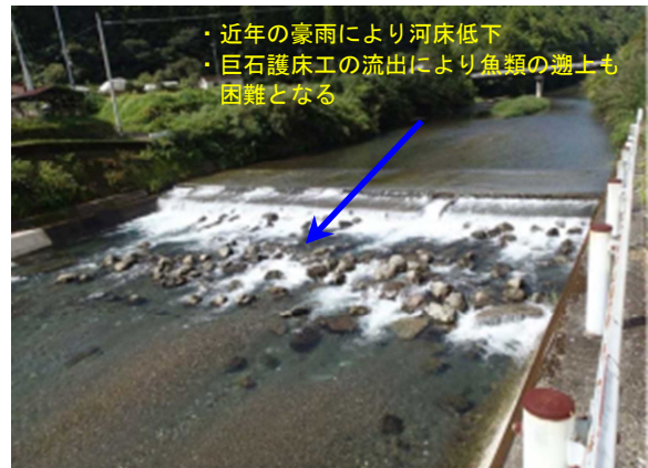
着工前（新莊川：津野町新土居）
