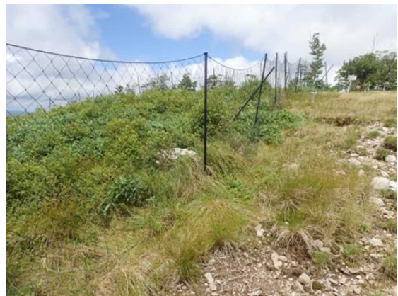
希少野生植物の食害被害を防止する防護柵
