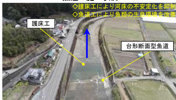
護床工及び魚道工完成
