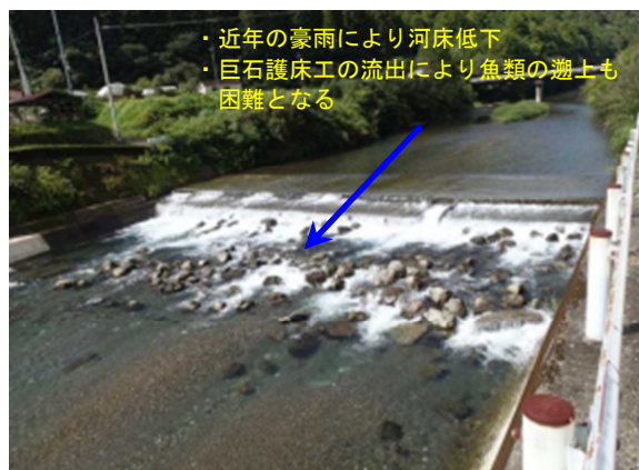
着工前（新莊川：津野町新土居）
