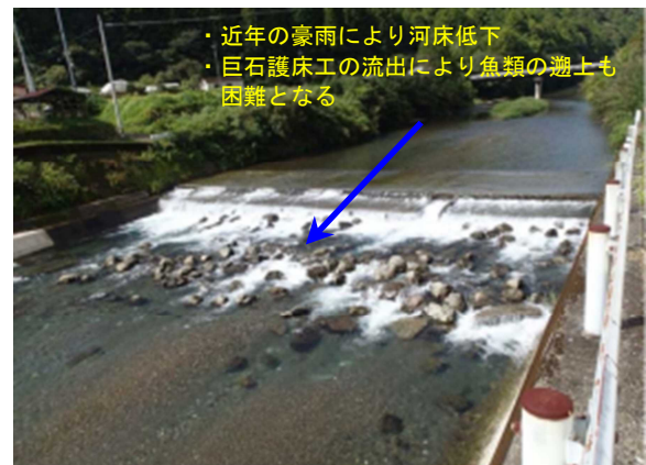
着工前（新莊川：津野町新土居）
