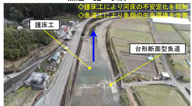
護床工及び魚道工完成
