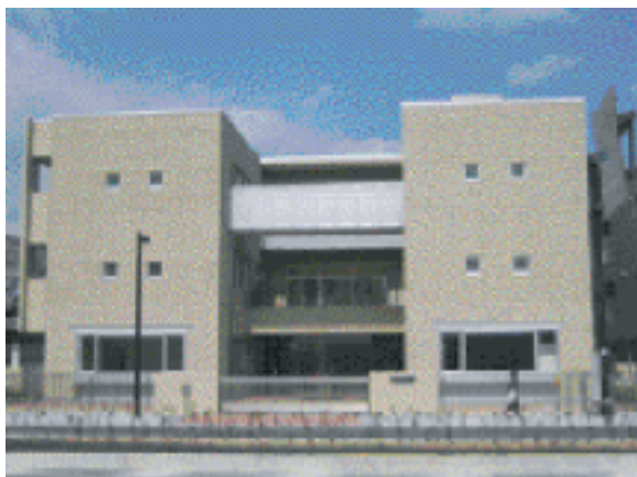
高知県女性相談支援センター（H20.3竣工）
