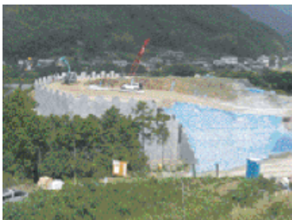
管理型最終処分場として建設中の エコサイクルセンター（日高村）
