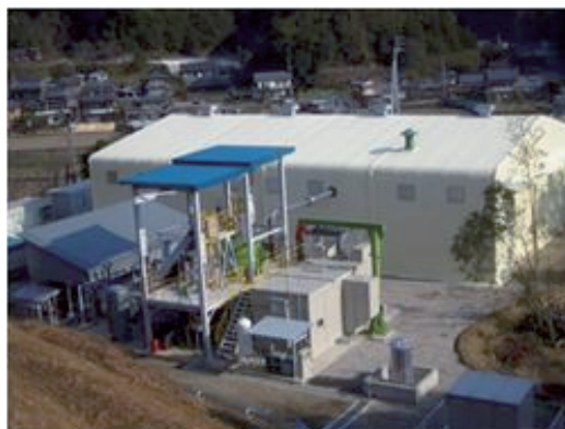
木質バイオマスを利用したガス化発電施設及びペレット製造工場（仁淀川町）
