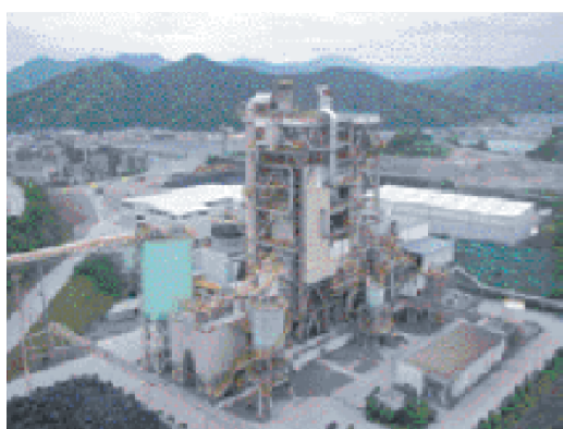
木質バイオマスを利用した火力発電施設（須崎市）
