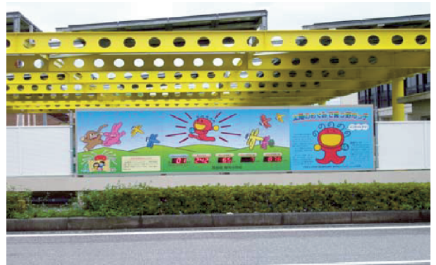
プール壁面に設置された太陽光表示パネル
