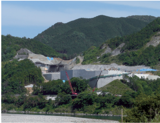
管理型最終処分場として建設中のエコサイクルセンター（日高村）
