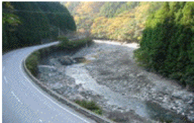
工事完了直後
