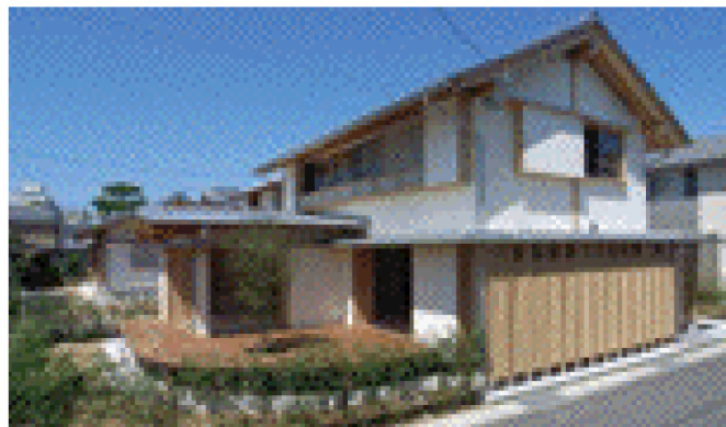
木造住宅（外観）
