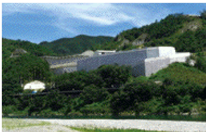
管理型最終処分場として建設中の エコサイクルセンター（日高村）
