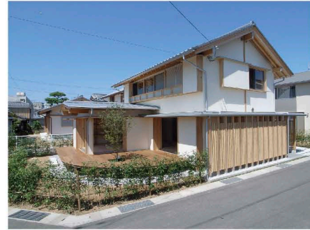
木造住宅(外観)
