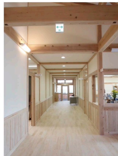
県産材により整備した県庁舎 (幡多児童相談所:内観)
