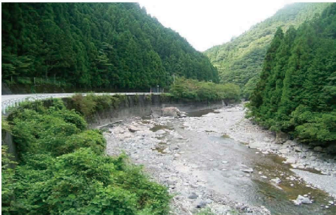
施工前(物部川:市宇地区)
