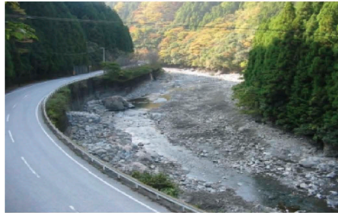
工事完了直後
