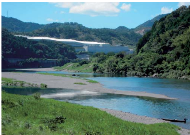
管理型最終処分場「エコサイクルセンター」
