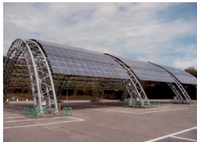
太陽光発電システム (のいち動物公園)
