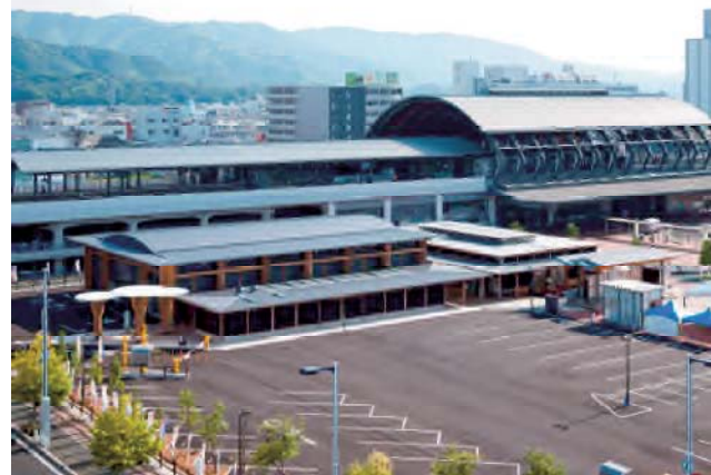
県産材により整備されたこうち旅広場の建築施設 (平成24年度 優良木造施設農林水産大臣賞受賞)
