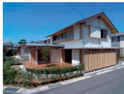
木造住宅 (外観)
