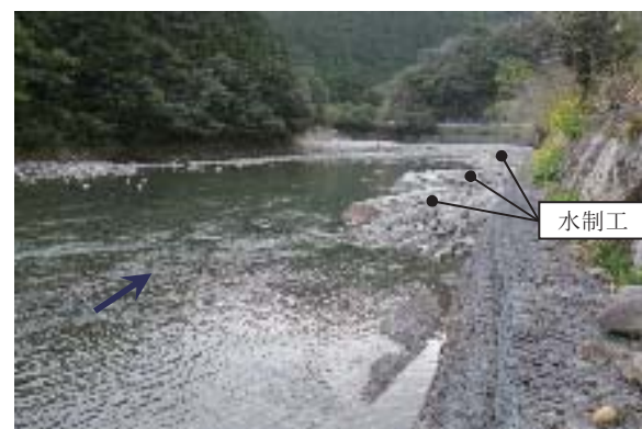
工事完了直後（H24. 3 月）
