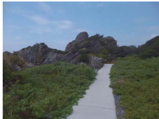
室戸岬園地遊歩道改修工事
