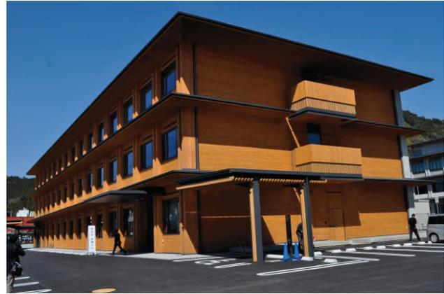
四万十町庁舎 (RC・鉄骨・木材の混構造 3 階建て)
