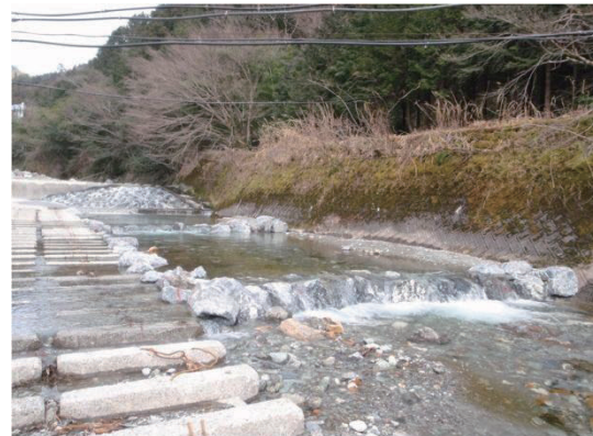
自然石帯工施工状況
