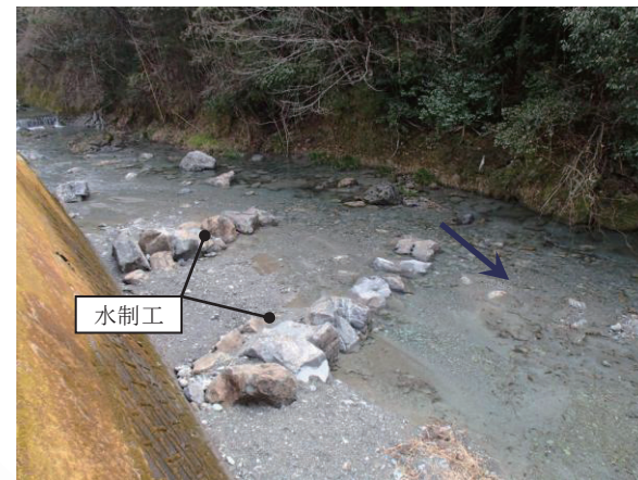
工事完了直後
