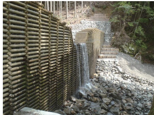
木製ダム施工状況
