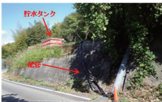
貯水タンク設置状況
