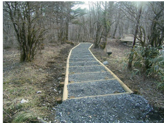
天狗園地遊歩道等改修工事
