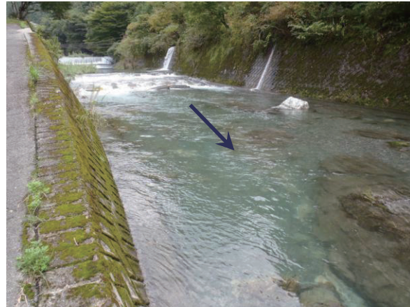
着工前（狩山川：仁淀川町見ノ越）
