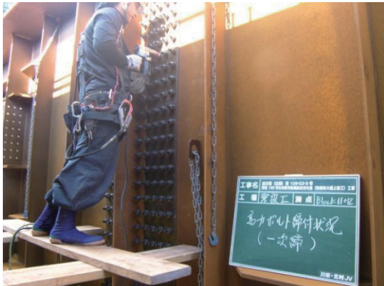
電動式工具による高力ボルト施工状況 (騒音対策)
