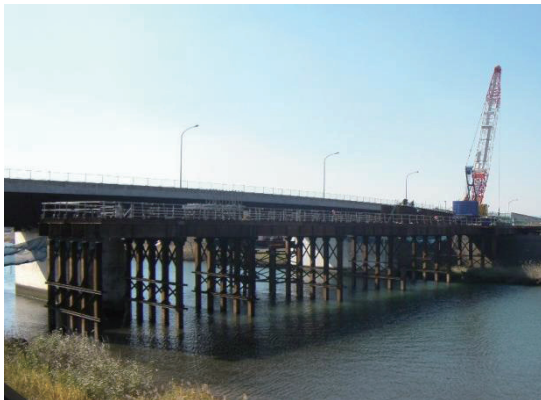
架設用棧橋設置状況
