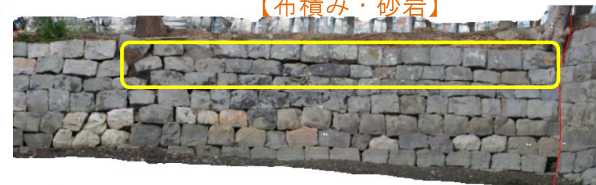
布積み 下方石灰岩転用石、花崗岩、上方砂岩
