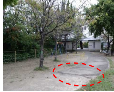
サクラの木の根によって園路が破壊されている様子
