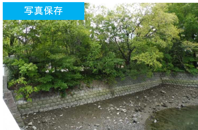
現在の横堀公園前の石積護岸
