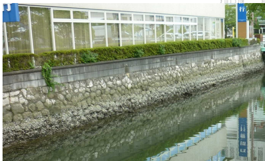
保全する石積護岸(四国銀行前)
