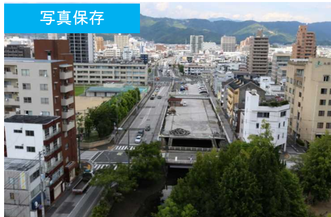
新堀川を駐車場が覆っている様子
