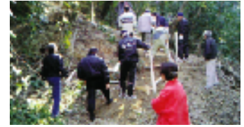
住民による避難路の整備 高知市浦戸地区（提供 高知市）
