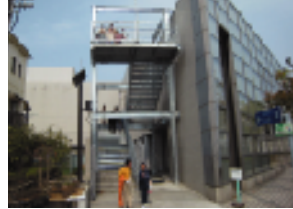
既存の建築物に外付け階段をつけた津波避難ビル（提供 香南市）
