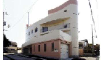
消防団屯所と合築した種崎地区津波避難センター（提供 高知市）
