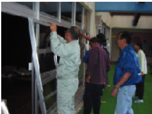
ガラスの飛散防止対策 (提供 安芸市)
