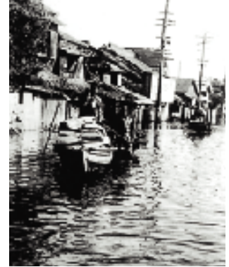
昭和南海地震後の高知市城見町付近の浸水の様子。地盤沈下での長期浸水により不自由な避難生活をしいられました。
