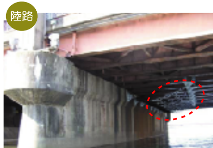
緊急輸送道路の落橋防止対策
