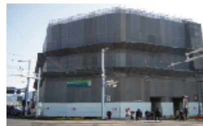
社屋の耐震化工事
