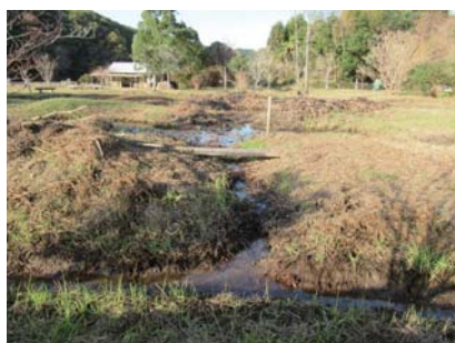
環境に配慮した 沈砂池及び排水施設のイメージ
