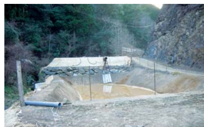
工事完了後の沈砂池のイメージ
