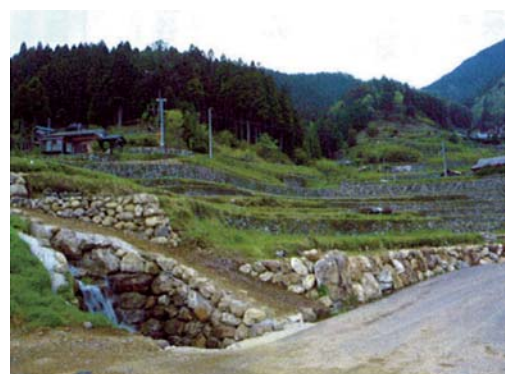
棚田の石垣を保全した例
