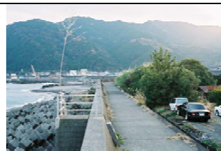
③護岸状況
