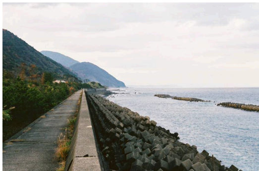
〔消波工と離岸堤（室戸市根丸海岸）〕
