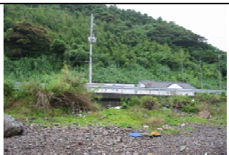
②堤防状況
