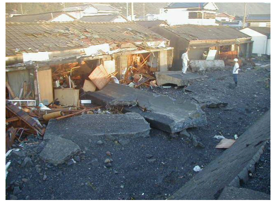
〔菜生海岸被災状況（室戸市）〕
