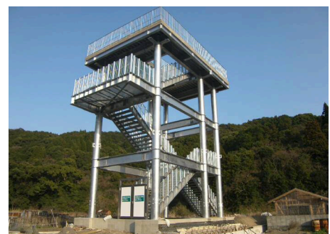
〔津波避難タワー（四万十町）〕
