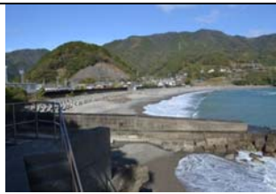
②護岸状況
