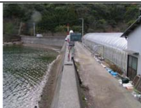
②護岸状況
