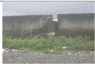
②護岸状況
