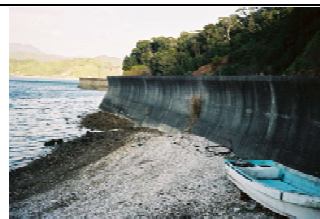
③護岸状況
