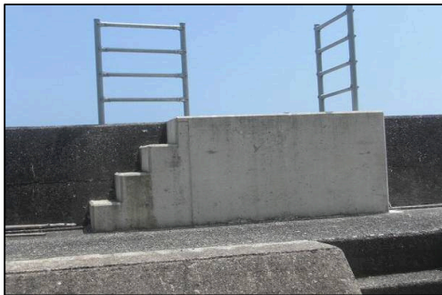
〔陸閘常時閉鎖 事例〕
