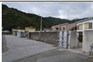
②護岸状況
