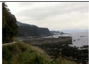
③護岸状況
