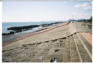
②護岸状況
