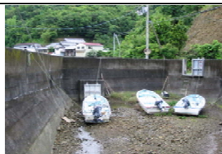
③水門状況
