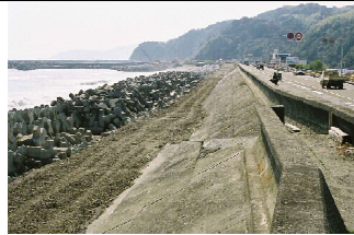
②護岸状況
