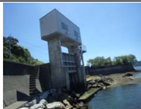
②水門状況
