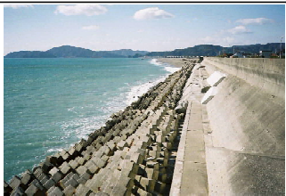
③護岸状況
