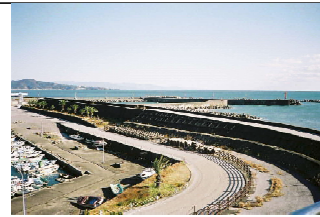
③護岸状況
