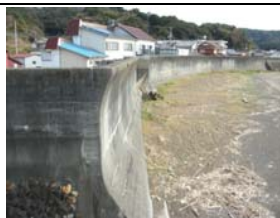
②護岸状況
