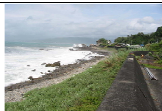
③海岸状況(西ノ浜地区)
