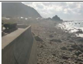
②護岸状況
