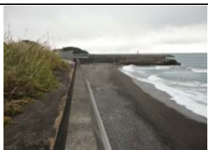
③海岸堤防状況
