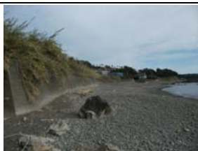
②護岸状況
