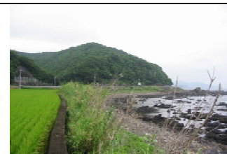
③護岸状況
