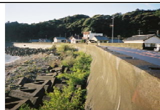
③護岸状況
