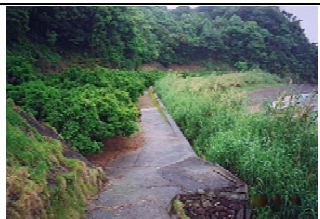
②護岸状況
