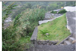
③護岸状況
