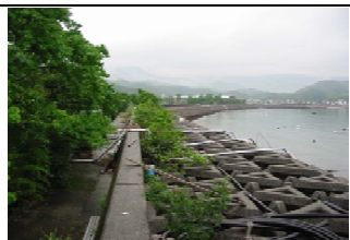
②護岸状況
