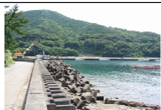
②護岸状況
