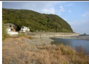
③護岸状況
