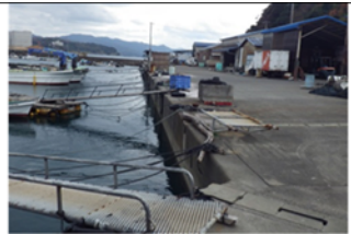
②護岸状況
