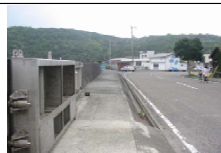
③背後地状況(三崎浦地区)
