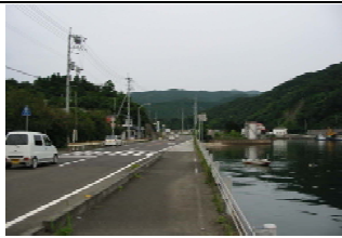
③護岸状況
