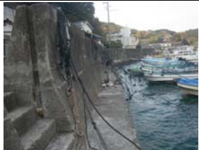
②護岸状況
