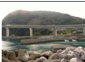
③護岸状況
