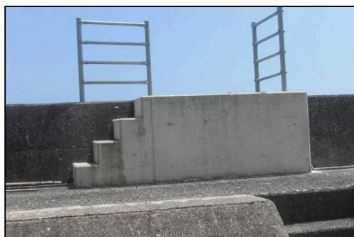
〔陸閘常時閉鎖 事例〕
