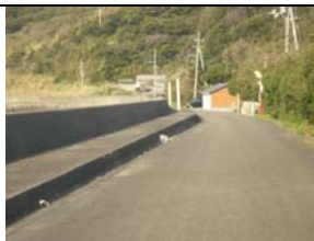
②護岸状況
