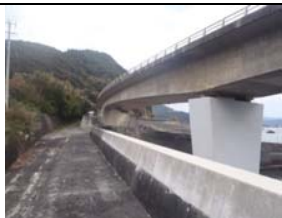
②護岸状況
