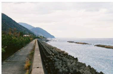
〔消波工と離岸堤(室戸市根丸海岸)〕
