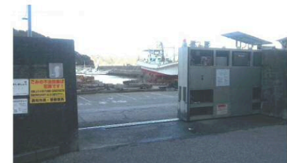
〔陸閘機械化 事例〕
