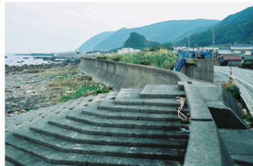
〔階段式護岸堤(室戸市丸山海岸)〕
