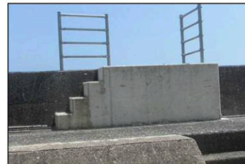
〔陸閘常時閉鎖 事例〕
