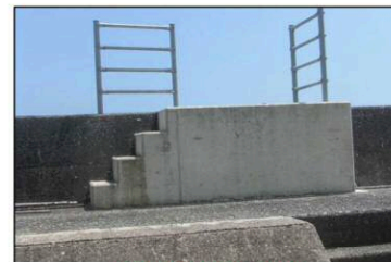
〔陸閘常時閉鎖 事例〕
