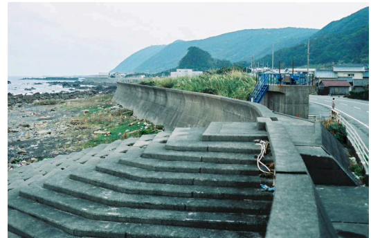
〔緩傾斜堤（室戸市丸山海岸）〕
