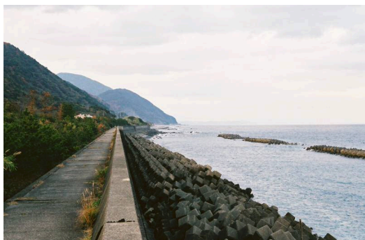
〔消波工と離岸堤（室戸市根丸海岸）〕
