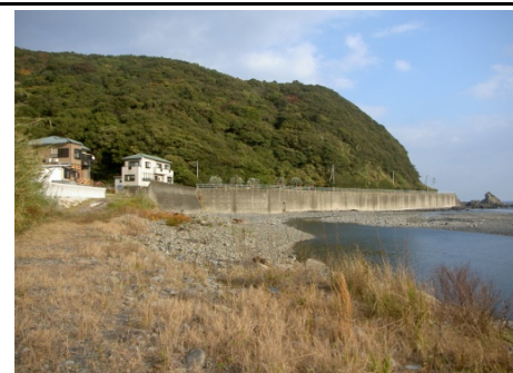
③護岸状況
