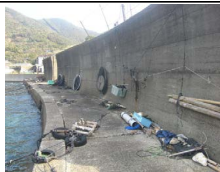
②護岸状況
